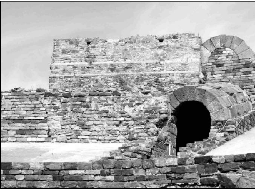
Ilustración 8.- Arranque de la torre medieval sobre el lado occidental de la cávea del teatro de Baelo.
