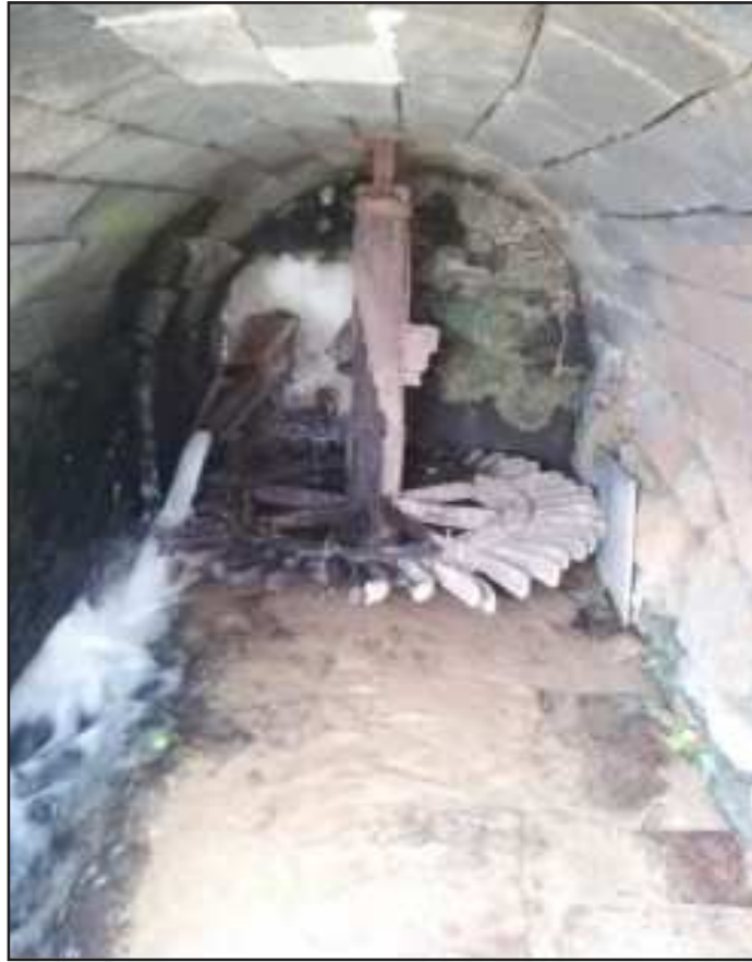
Ilustración 2.- Cárcavo, saetín, rodezno y árbol. Molino de Luis Gil, Garganta del Rayo.
