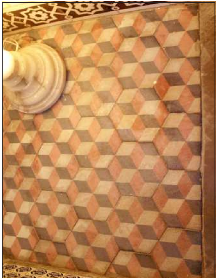
Ilustración 10.- Pavimento de mosaico hidráulico con motivos geométricos. Calle Silos, 9
