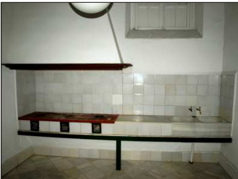
Ilustración 6.- Cocina con azulejos, humera y pila de mármol. Calle Coronel Francisco Valdés, 4.
