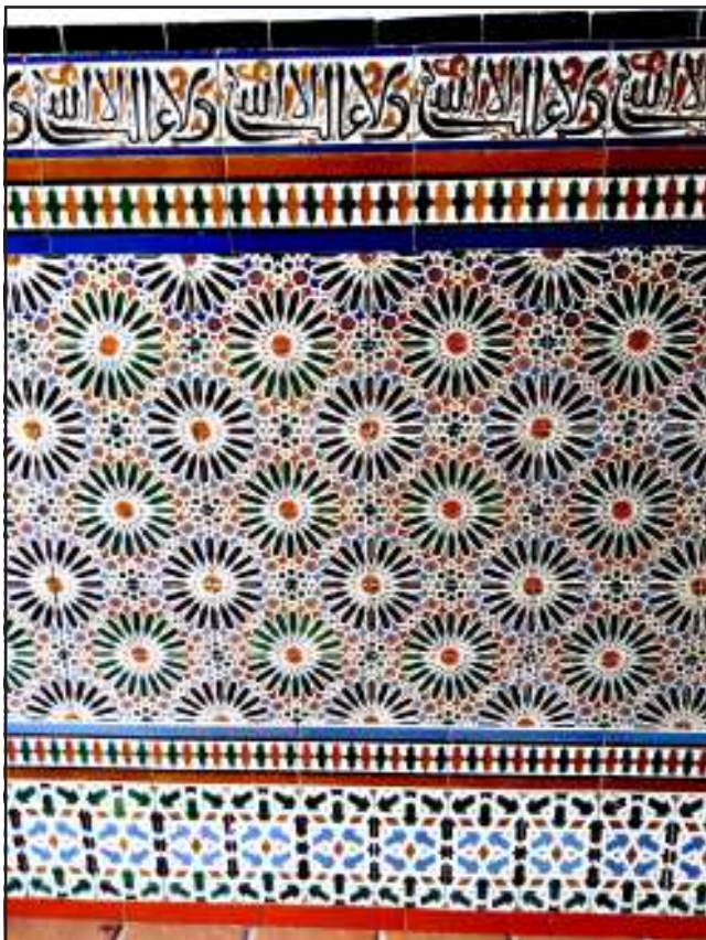
Ilustración 2.- Zócalo de azulejos de cuenca o arista. Calle Santísima Trinidad, 27.
