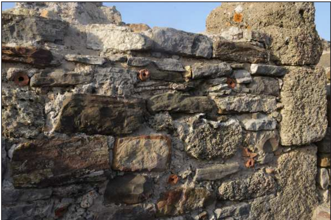
Ilustración 3.- Detalle de una de las estancias calefactadas. Muro con clavijas de cerámica para sujeción de dobles paredes. Termas de Baelo (Tarifa, Cádiz). @Proyecto MarqHis II. Foto Juan Blázquez.
