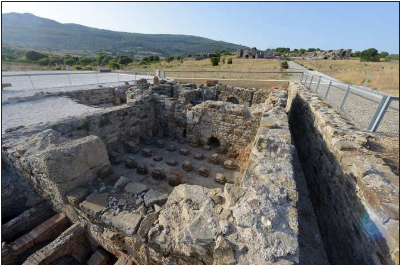
Ilustración 1.- Vista general del la parte excavada del edificio termal, desde el sureste. Termas de Baelo (Tarifa, Cádiz). @Proyecto MarqHis II. Foto Juan Blánquez.
