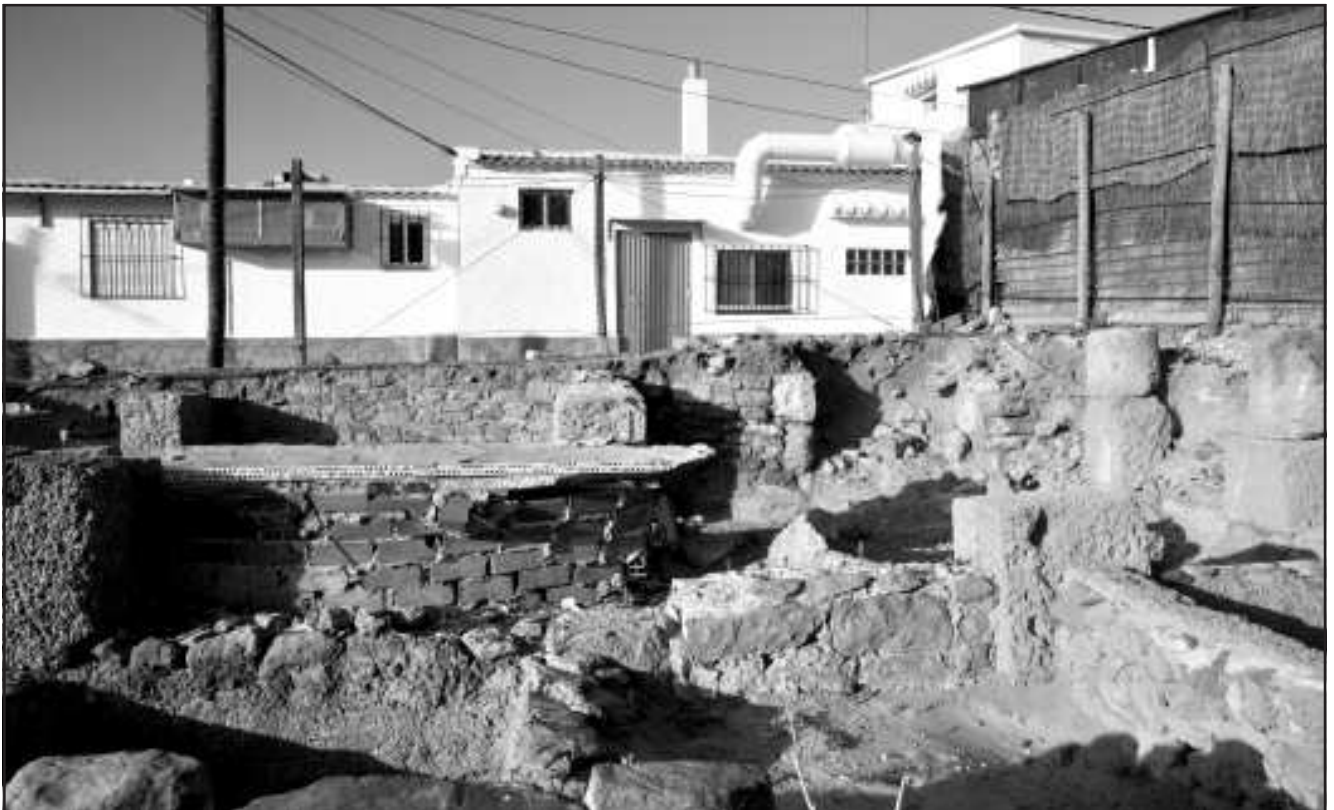
Ilustración 3.- Vista de la fosa séptica construida en la década de los ochenta.
