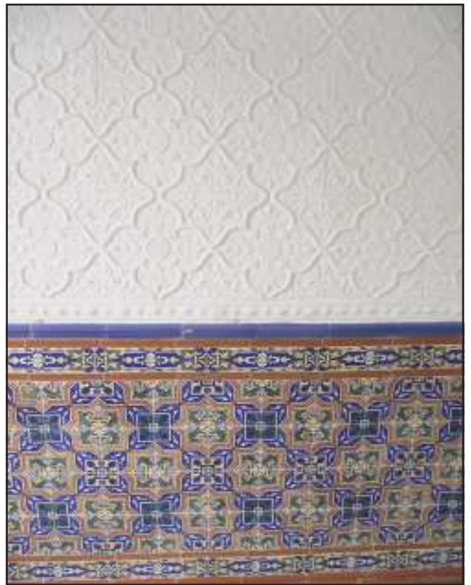
Ilustración 3.- Zócalo de azulejos lisos y por encima placas cerámicas en relieve, encladas. Calle Nuestra Señora de la Luz, 5.
