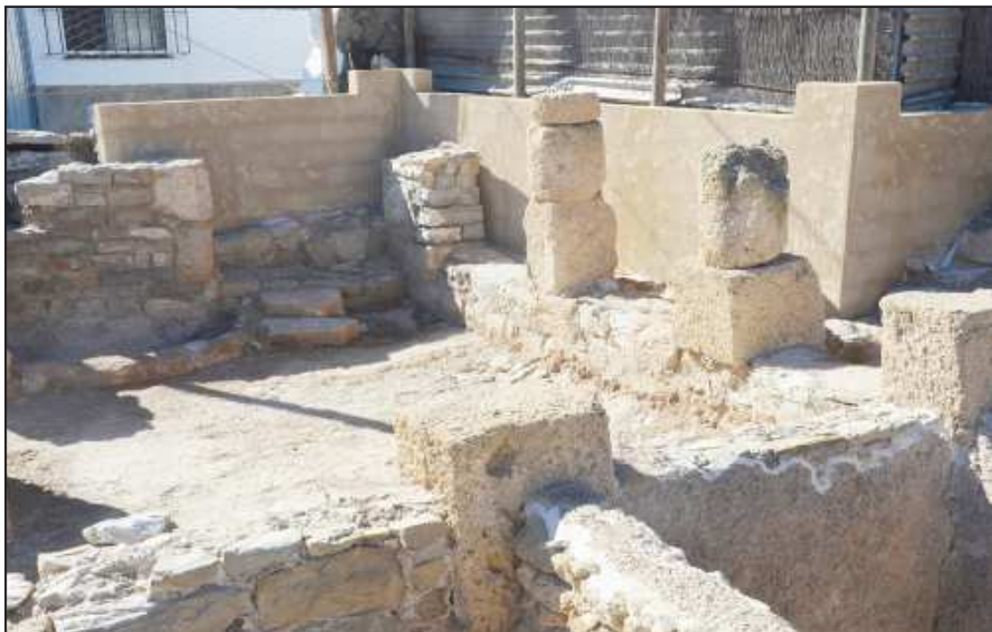
Ilustración 9.- Vista general de los muros de contención en el límite del área excavada en la zona suroeste del C.I. XI, ejecutados al final de la campaña estival de 2017.
