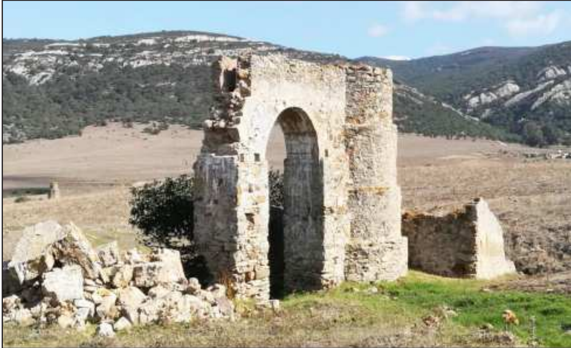
Ilustración 4.- Molinos del cortijo de la Haba. El primer molino, atarjea con arco, cubo, sala de molienda. Segundo molino a la izquierda de la imagen, cubo y atarjea. En el fondo el Aciscar.
