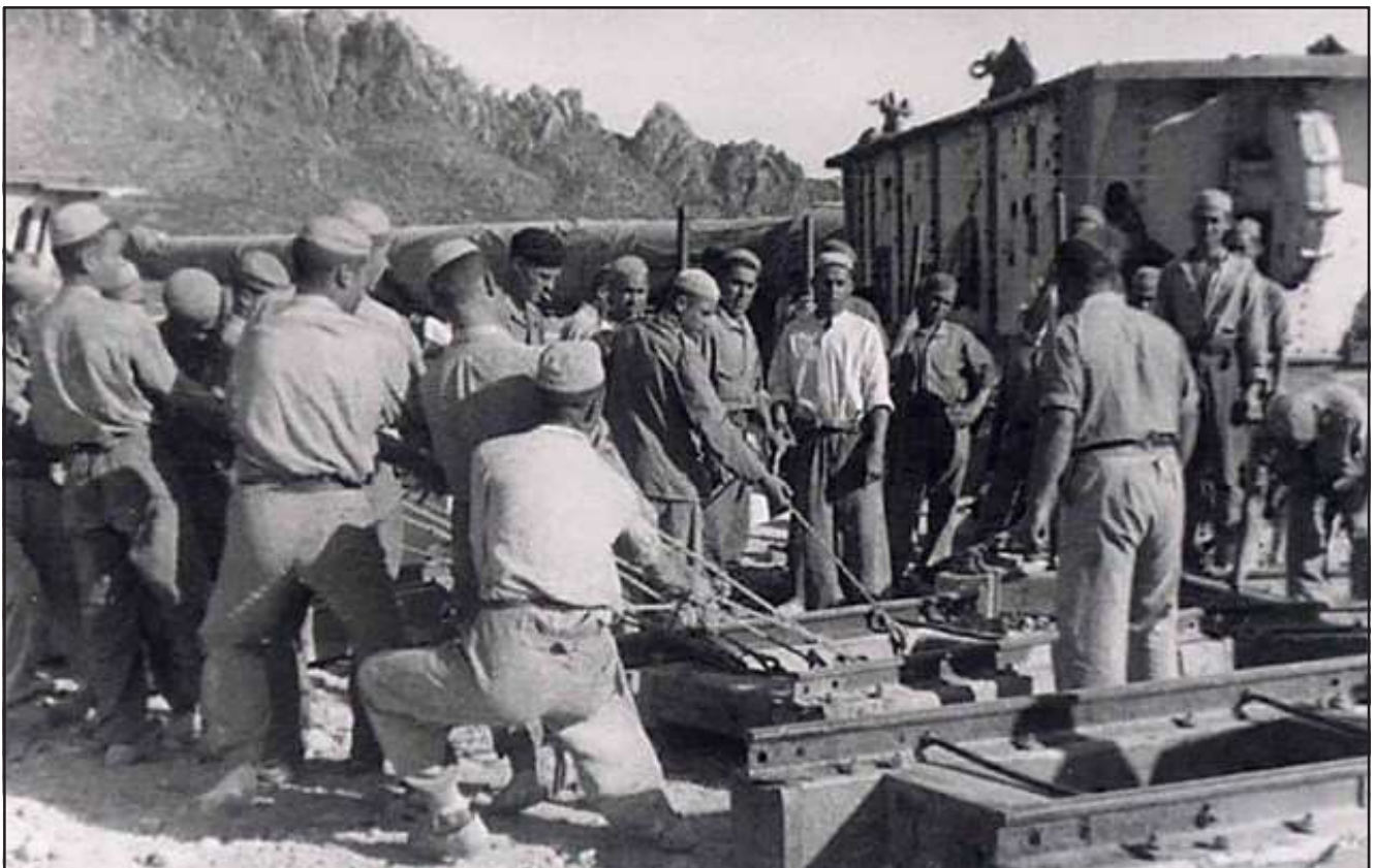
Ilustración 4.- Presos colocando los raíles necesarios para poder transportar el cañón 38,1 de Punta Paloma. Podemos ver a los presos con gorro cilíndrico blanco, camisa blanca de tela fuerte, pantalón caqui, y alpargata.
