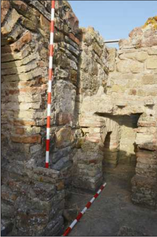
Ilustración 2.- Muro oeste del caldarium con los arcos del hypocaustum y parte de la suspensura . Termas de Baelo (Tarifa, Cádiz). @Proyecto MarqHis II. Foto Juan Blázquez.
