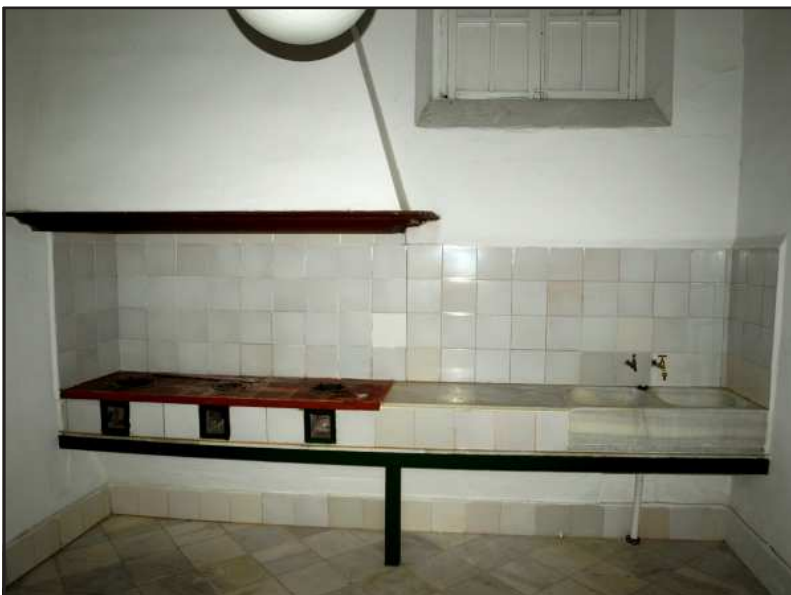
Ilustración 6.- Cocina con azulejos, humera y pila de mármol. Calle Coronel Francisco Valdés, 4.
