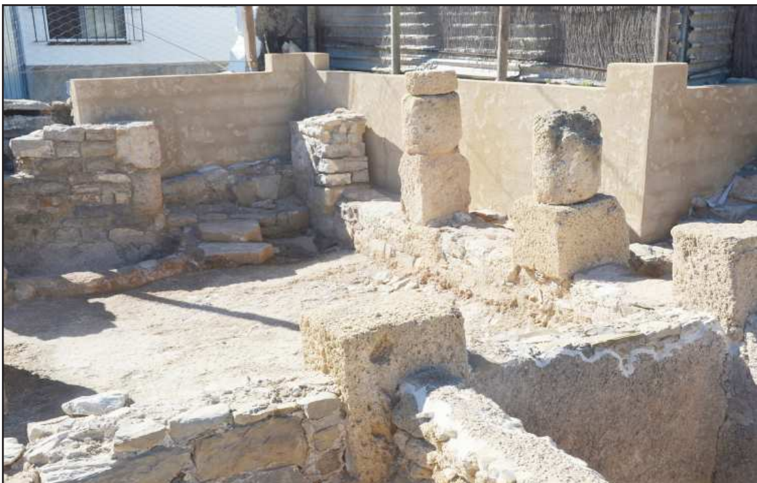
Ilustración 9.- Vista general de los muros de contención en el límite del área excavada en la zona suroeste del C.I. XI, ejecutados al final de la campaña estival de 2017.
