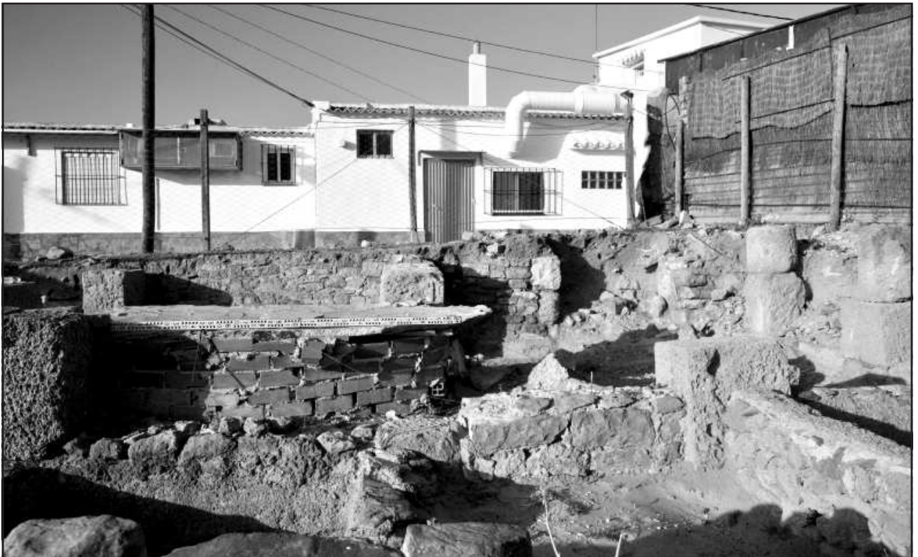
Ilustración 3.- Vista de la fosa séptica construida en la década de los ochenta.
